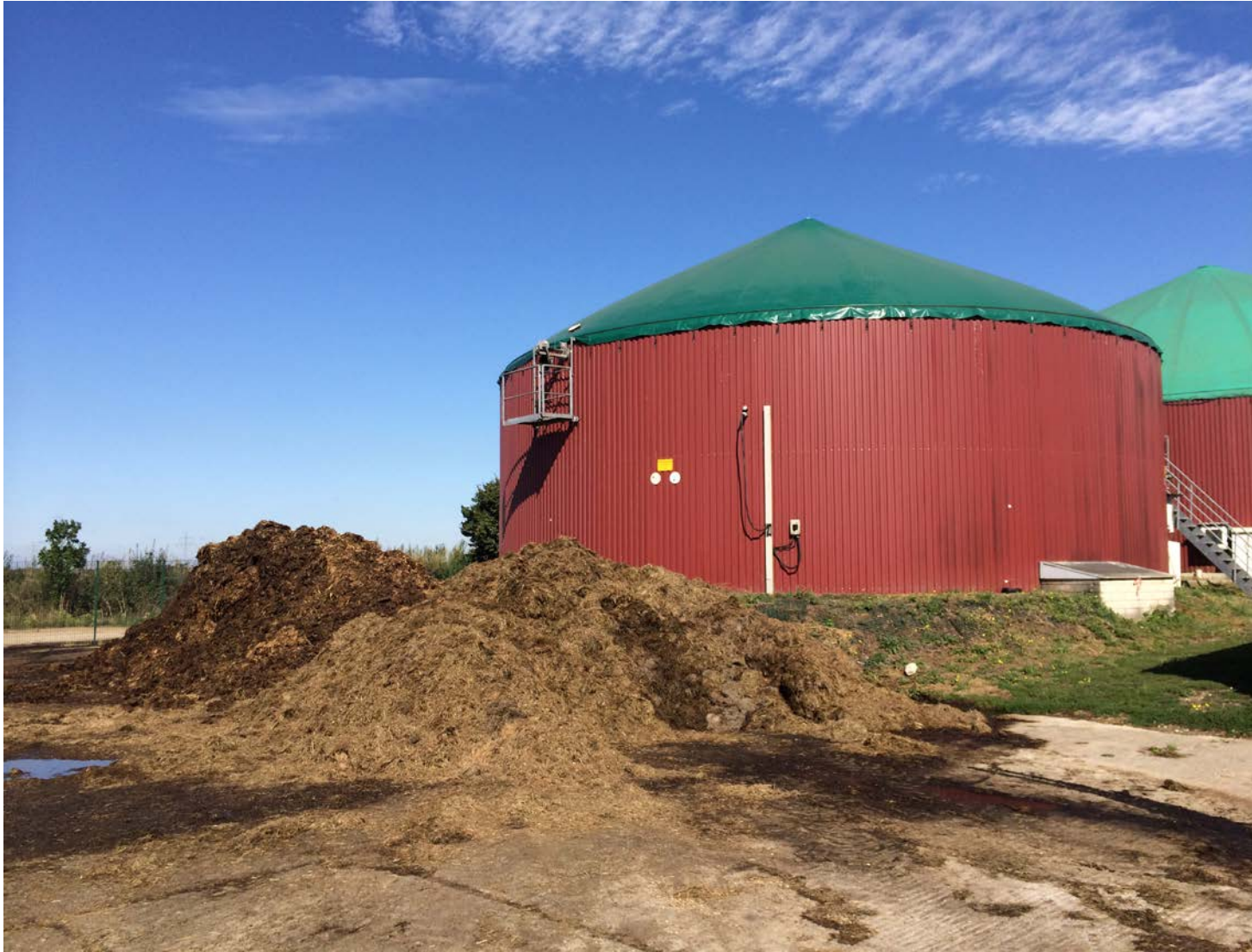
Biogasanlage. Foto: Fraunhofer IFF
