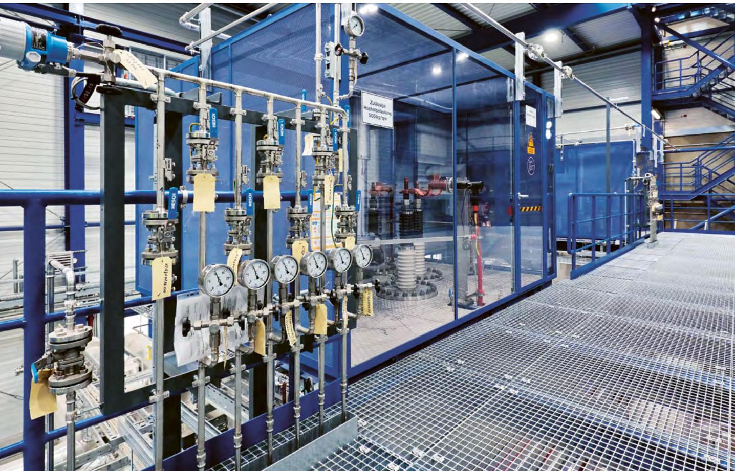
▲ Ebene 1 der Power-to-Fernwärme-Anlage, Blick auf die Köpfe der Elektroden und eine Entleerungsgruppe.
