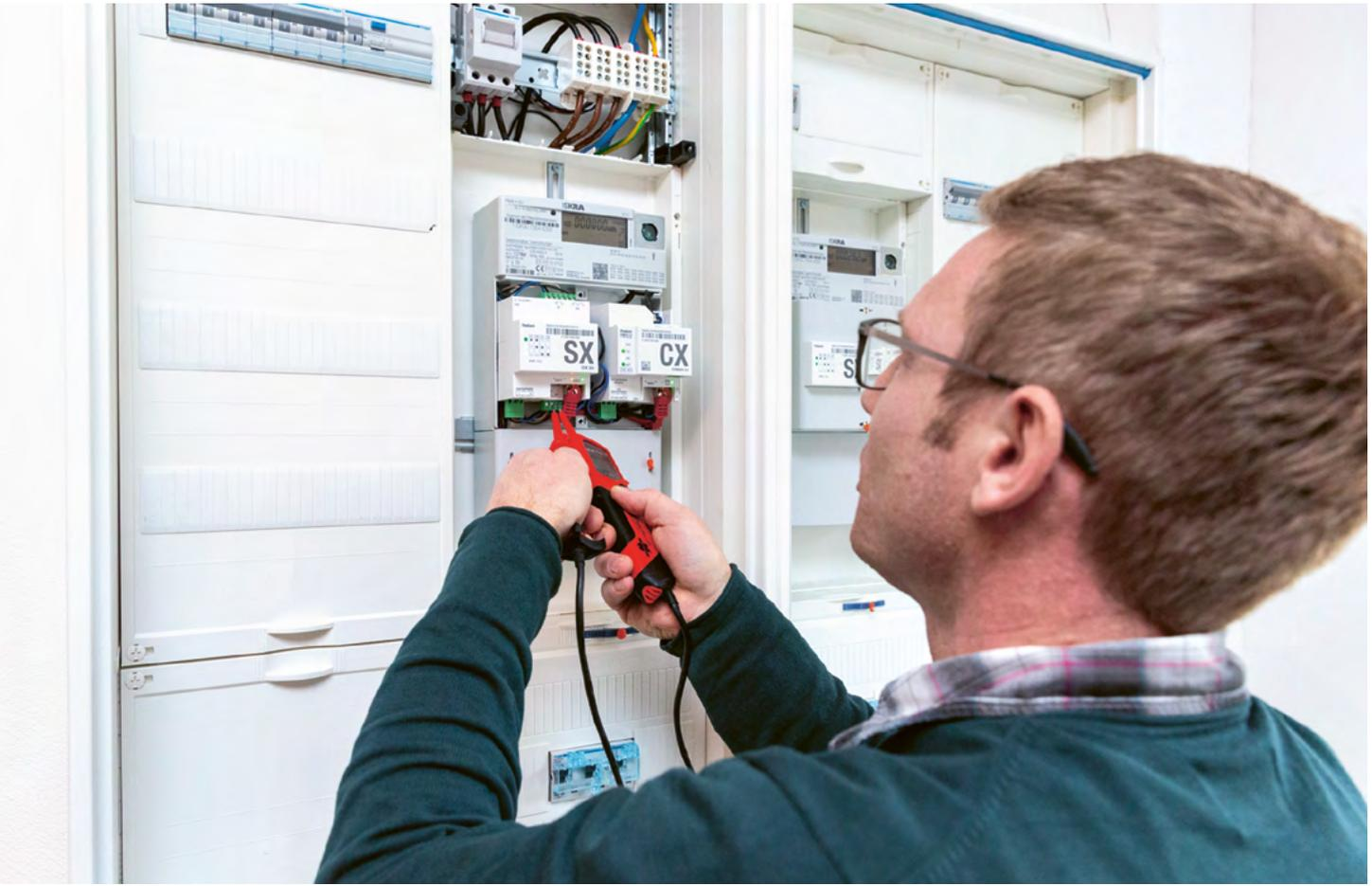
▲ Abnahme und Testschaltungen des ersten verbauten intelligenten Messsystems mit Steuerbox. Dieses schaltet hier die Fahrweise einer Wärmepumpe.
