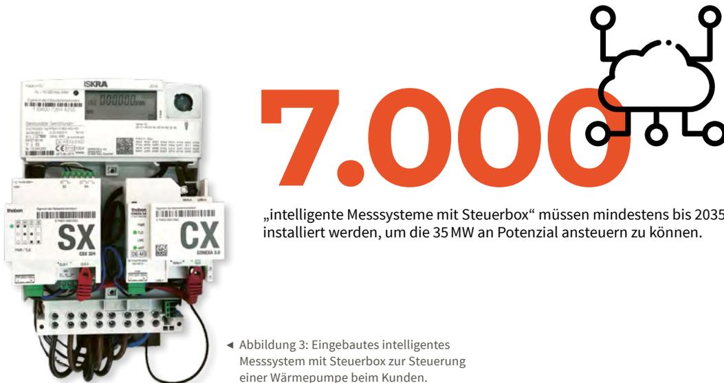
◀ Abbildung 3: Eingebautes intelligentes Messsystem mit Steuerbox zur Steuerung einer Wärmepumpe beim Kunden.
