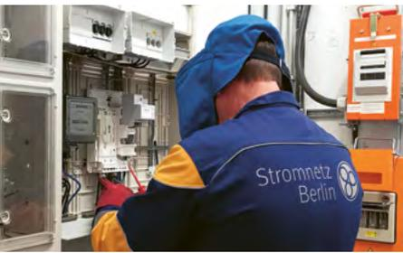
▲ Installation eines intelligenten Messsystems mit PLC-Kommunikation im Ullsteinquartier.
