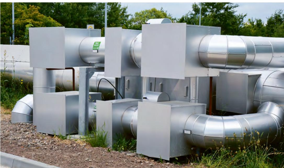
▲ Wärmeverteileranlage im Fernwärmenetz von Frankfurt (Oder).
